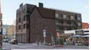
Aanzicht L-gebouw vanaf de bushalte
